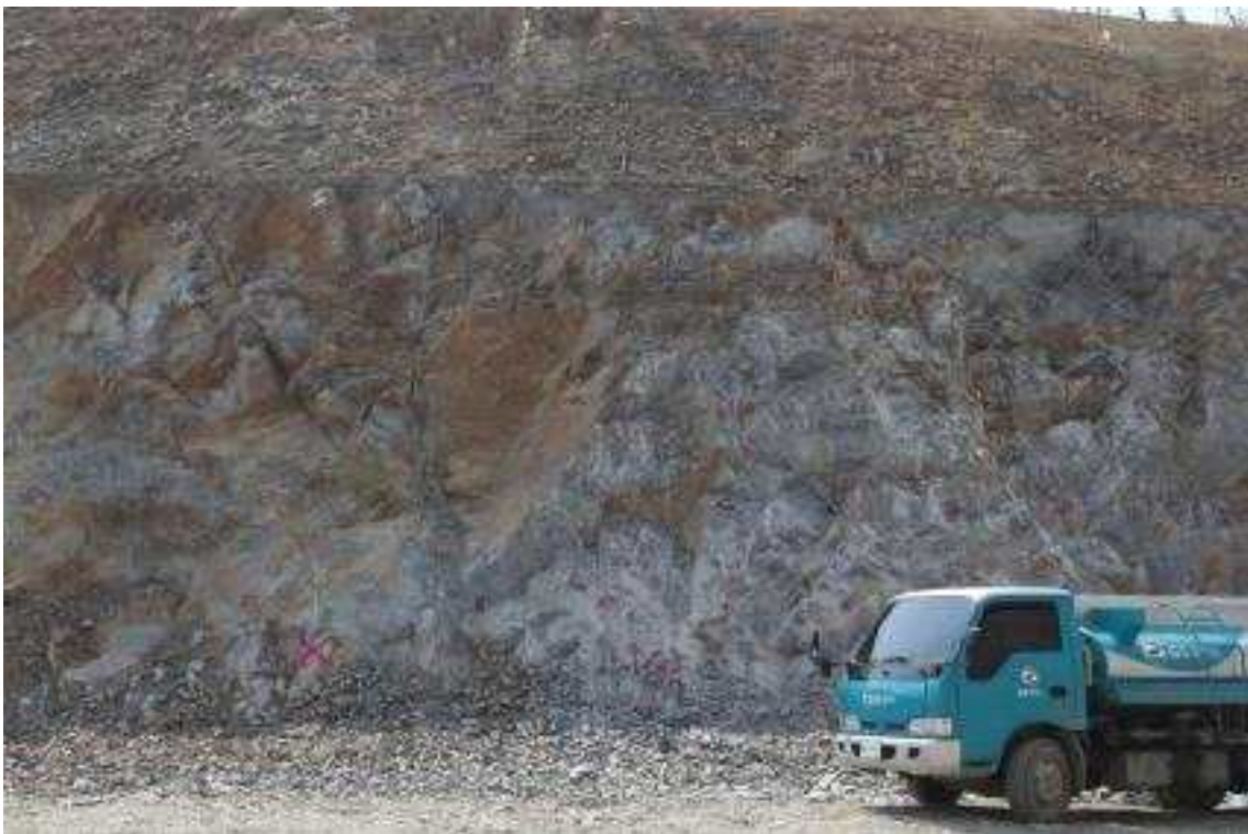
R-A STA.1+170 하단부
