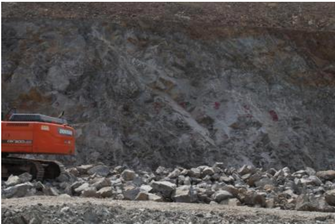
R-A STA.1+140 하단부
