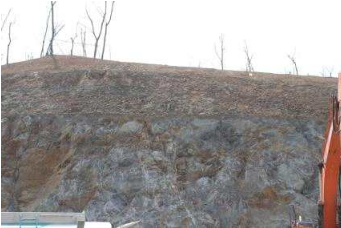
R-A STA.1+160 상단부
