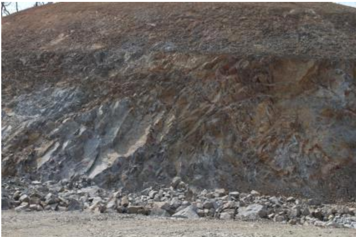
R-D STA.0+130 하단부
