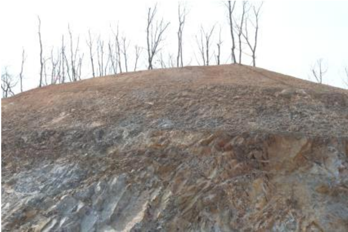
R-D STA.0+130 상단부
