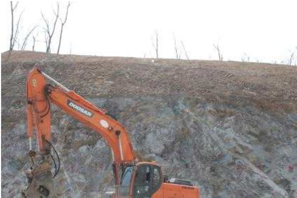
R-A STA.1+150 상단부
