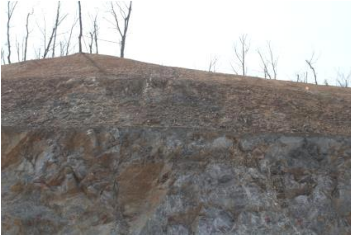
R-A STA.1+170 상단부
