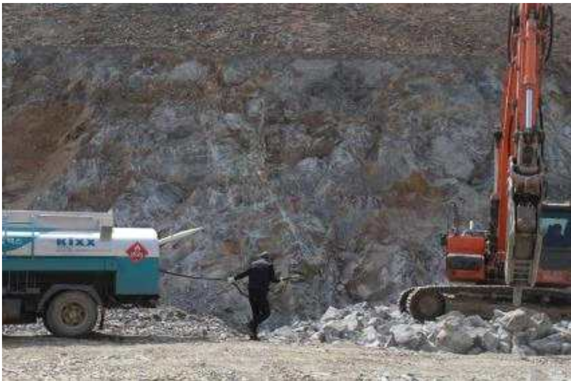
R-A STA.1+160 하단부
