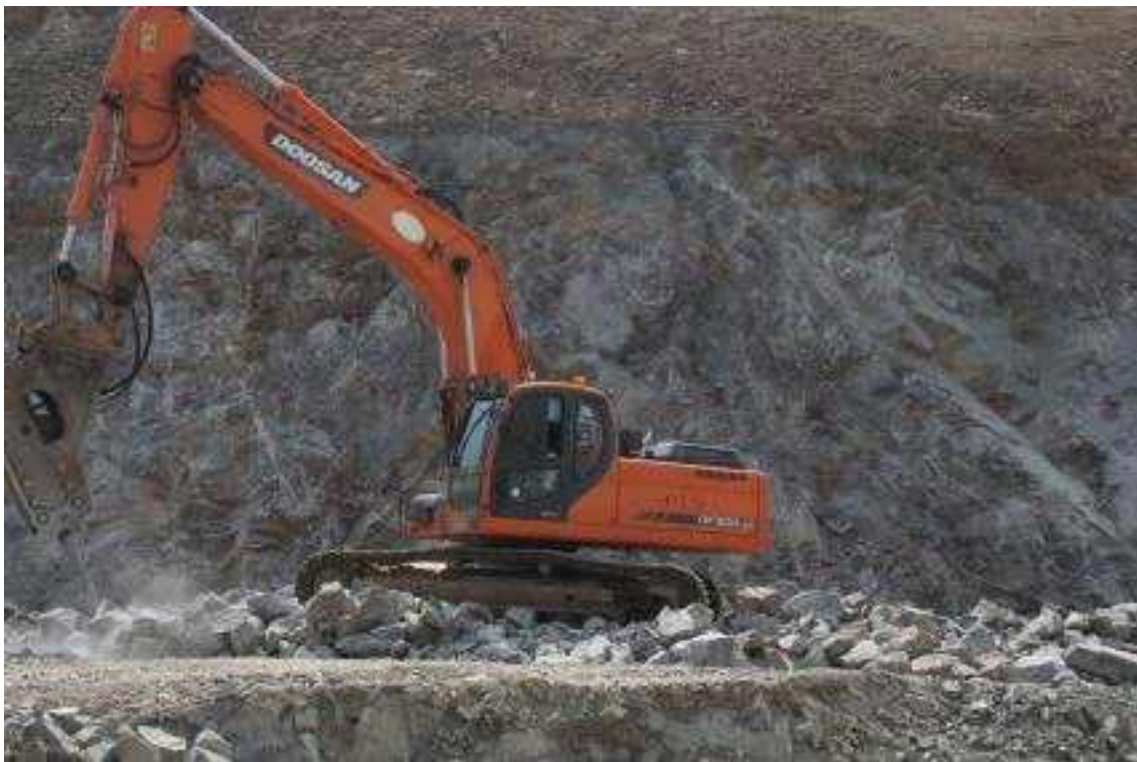
R-A STA.1+150 하단부
