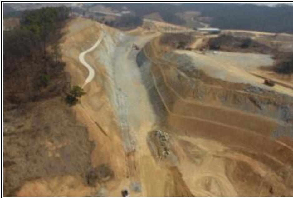
【그림 3】 깎기비탈면 시점부 측면 사진
