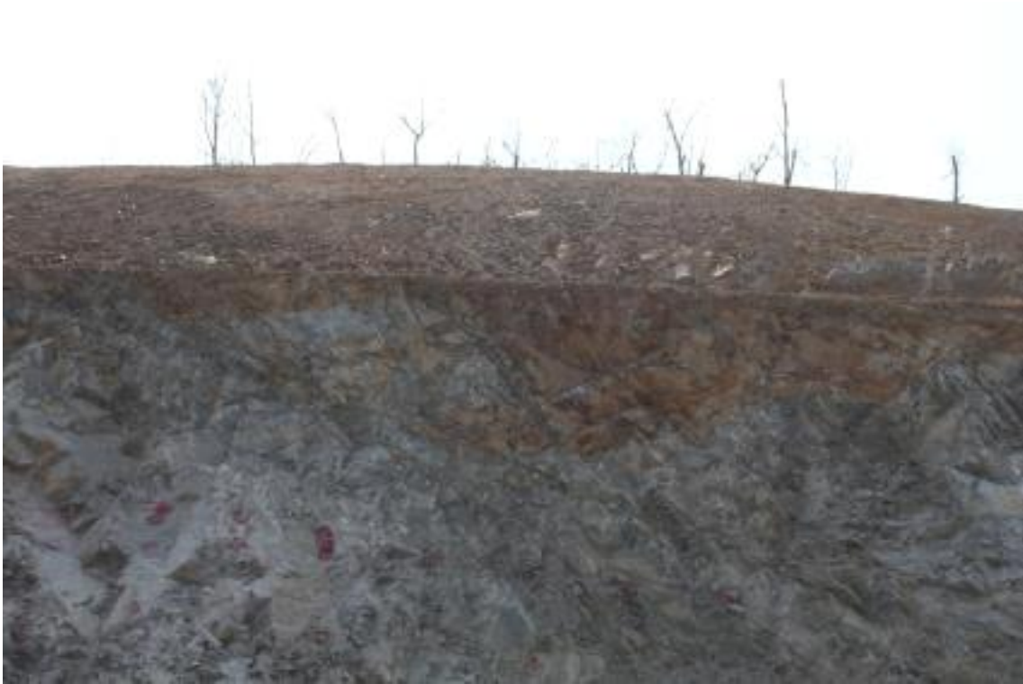
R-A STA.1+120 상단부
