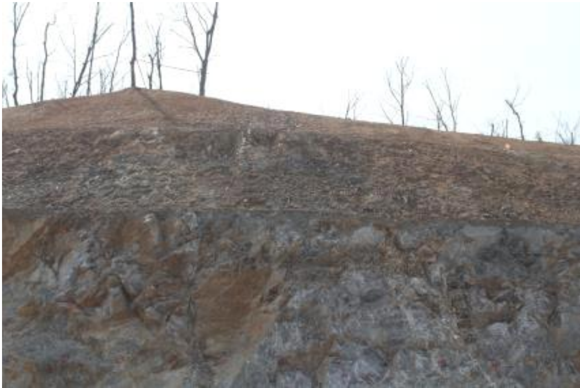
R-D STA.0+120 상단부
