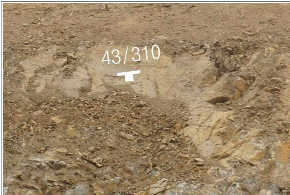
【그림 20】 D 영역에 발달한 불연속면(1)
