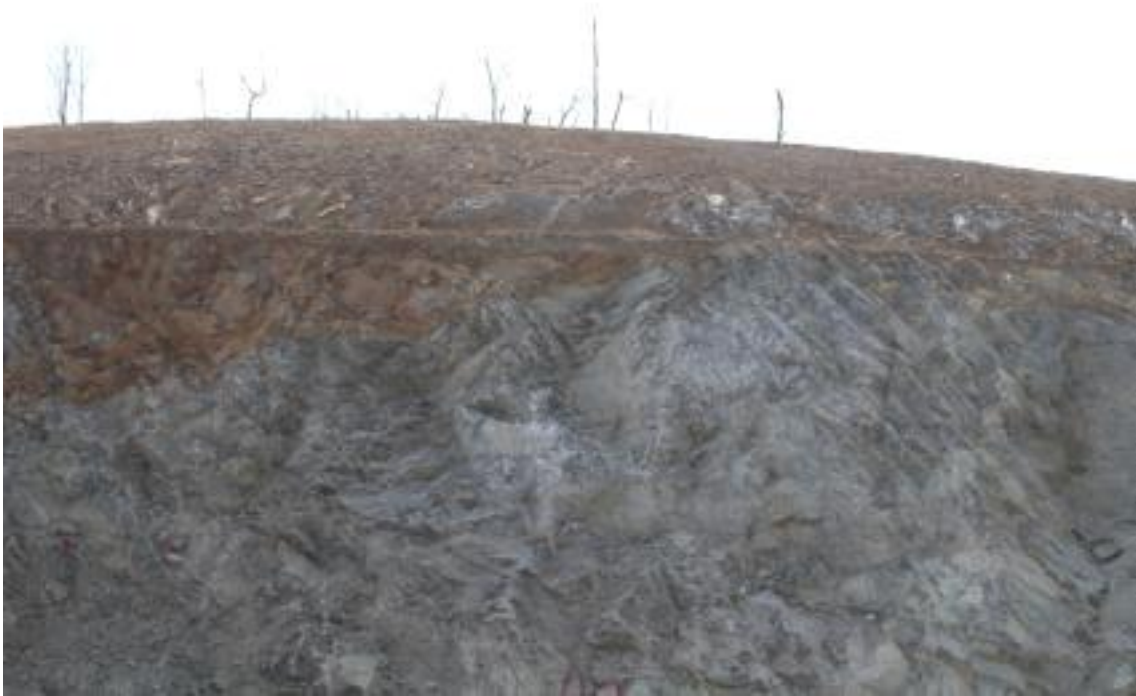
R-A STA.1+110 상단부
