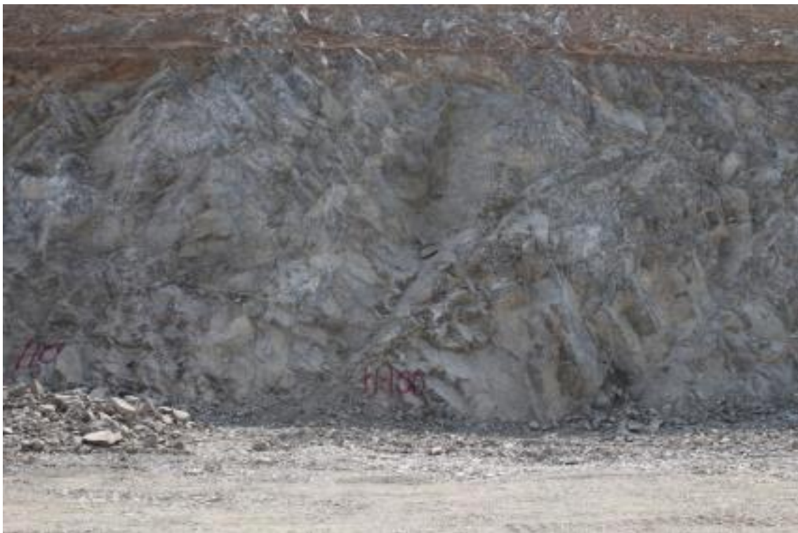
R-A STA.1+100 하단부
