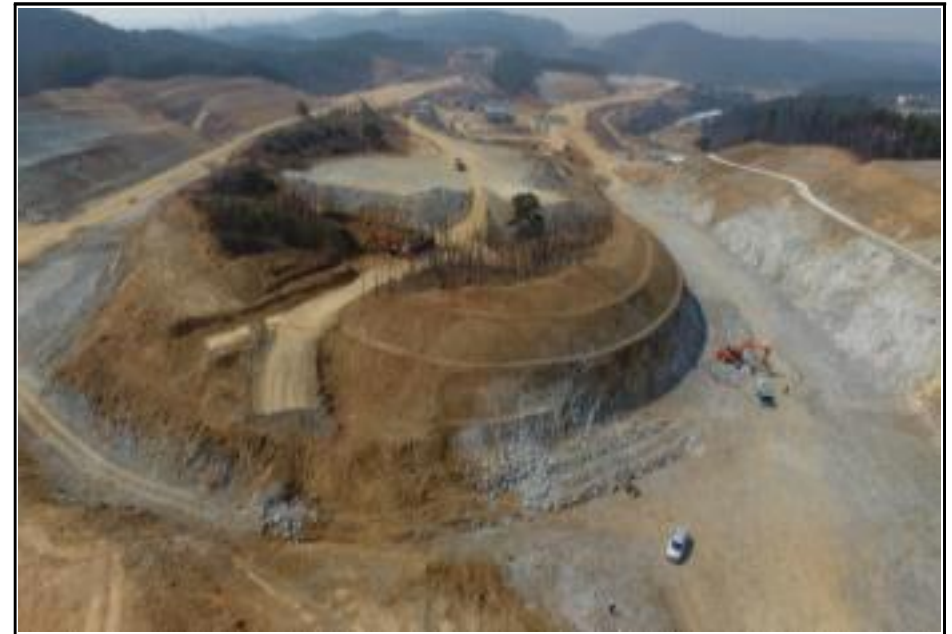
【그림 4】 깎기비탈면 종점부 측면 사진
