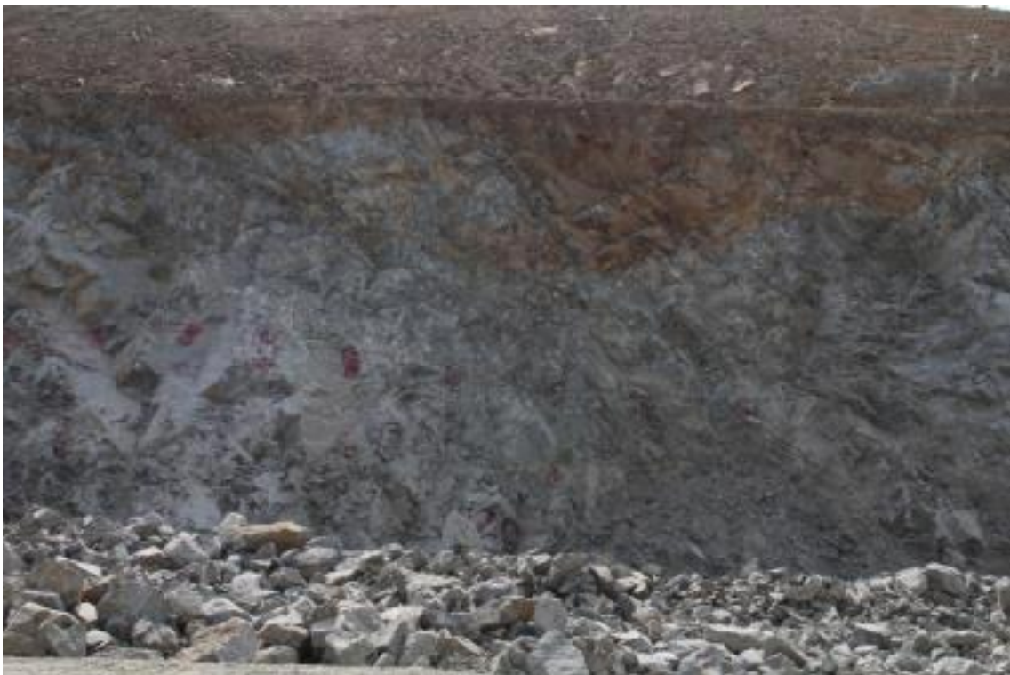
R-A STA.1+120 하단부
