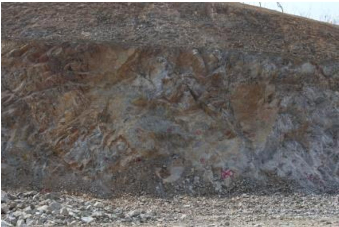
R-D STA.0+120 하단부
