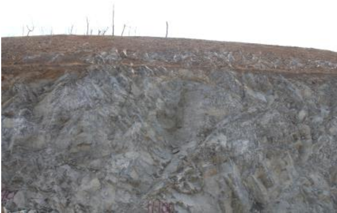
R-A STA.1+100 상단부
