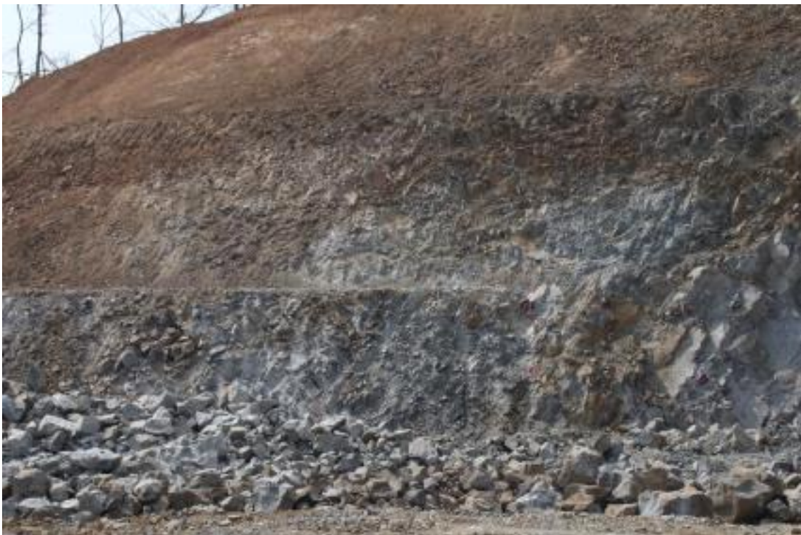
R-D STA.0+140 하단부
