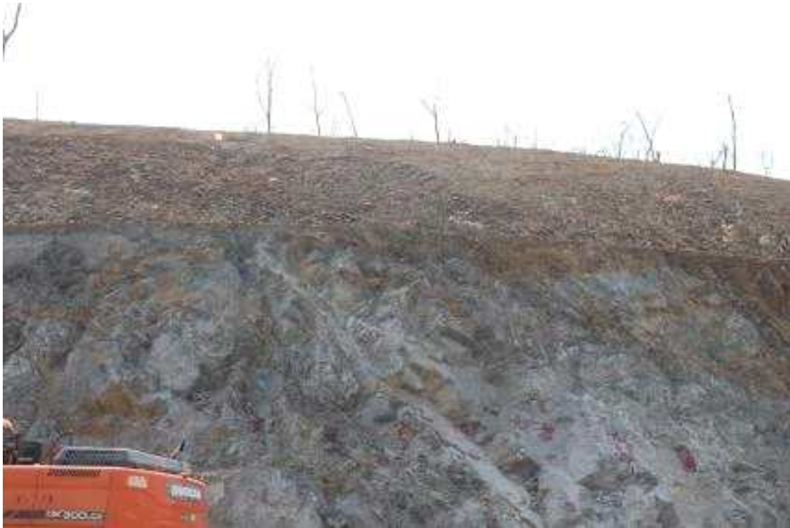
R-A STA.1+130 상단부
