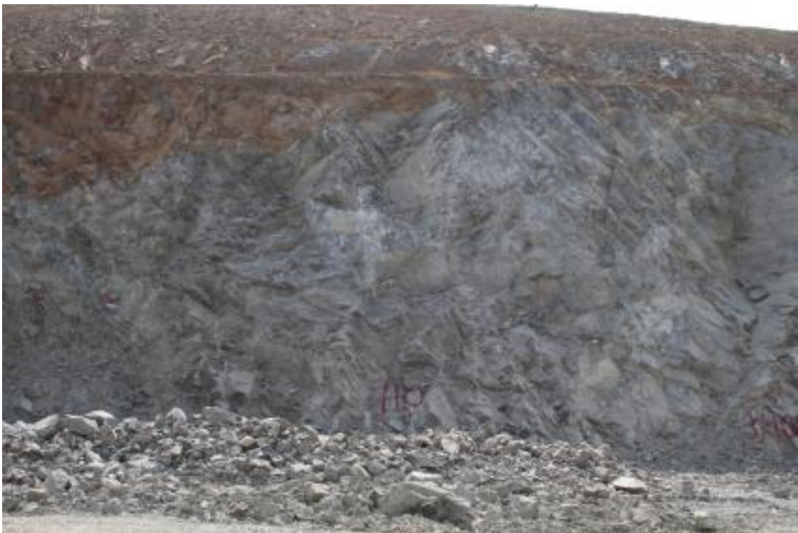
R-A STA.1+110 하단부
