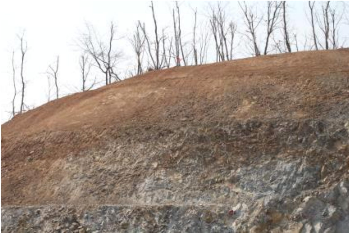
R-D STA.0+140 상단부
